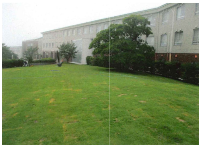
共通棟南側芝生張替等工事(施工後)
