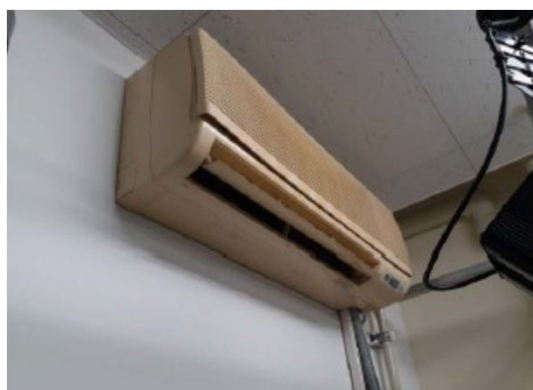
先導科学研究科棟1階113実験室(暗室) 空調機更新工事(施行前)
