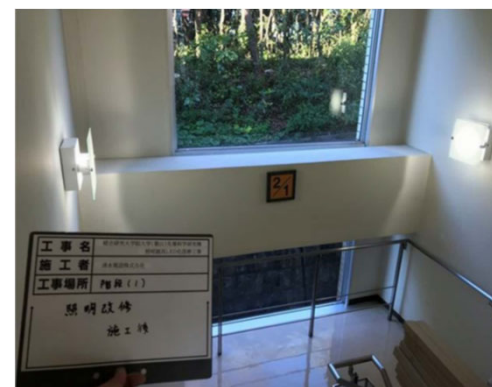
先導科学研究科棟照明器具LED化工事(施行後)
