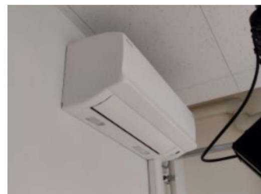
先導科学研究科棟1階113実験室(暗室) 空調機更新工事(施行後)
