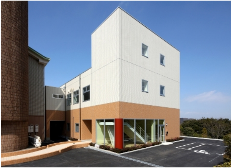
《 学融合推進センター棟（東面） 》
