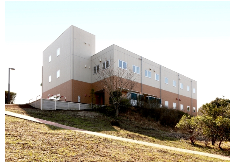
《 学融合推進センター棟（北面） 》
