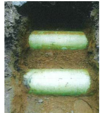
埋設管外部写真
