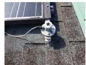
太陽電池装置：日照計の設置状況
